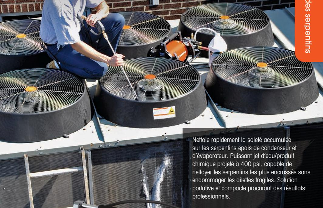
Nettoie rapidement la saleté accumulée sur les serpentins épais de condenseur et d'évaporateur. Puissant jet d'eau/produit chimique projeté à 400 psi, capable de nettoyer les serpentins les plus encrassés sans endommager les ailettes fragiles. Solution portable et compacte procurant des résultats professionnels.
