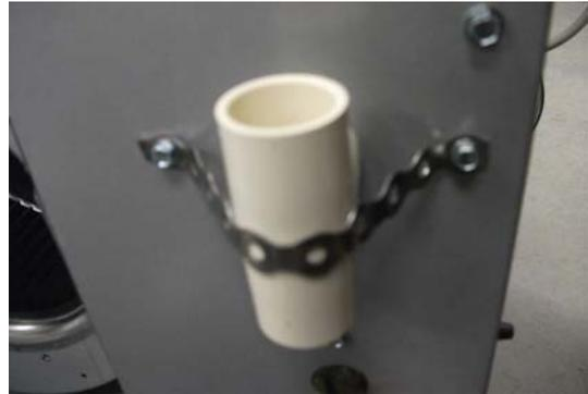
4. Pour une sécurité additionnelle, si désiré, il est recommandé de fixer une bande métallique autour du purgeur. Utilisez les vis du purgeur de condensat pour fixer la bande métallique.
