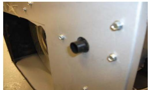
2. Si vous faites l'installation avec du PVC, utilisez le tuyau de 1/2". Si vous faites l'installation avec du PVC-C, utilisez le tuyau de 5/8". Glissez le tuyau approprié sur la sortie du purgeur de condensat et coupez-le à égalité avec l'extrémité de la sortie. Le tuyau de caoutchouc restant devrait être à égalité avec la sortie du purgeur de condensat. La longueur du tuyau restant devrait convenir à toutes les orientations de la fournaise
