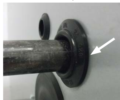
FIGURE 27 - RACCORDEMENTS DE LA CONDUITE DE GAZ DE LA FOURNAISE (NOTEZ L'ANNEAU EN CAOUTCHOUC)
