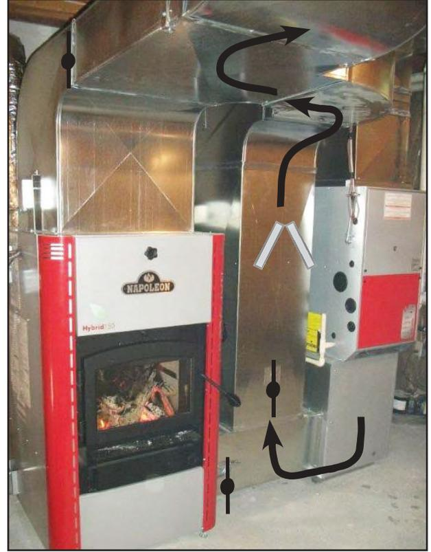
Les trois registres sont en position verticale, bloquant la circulation d'air dans les conduits de retour et d'alimentation de la fournaise à bois et la forçant dans le serpentin évaporateur du climatiseur.
