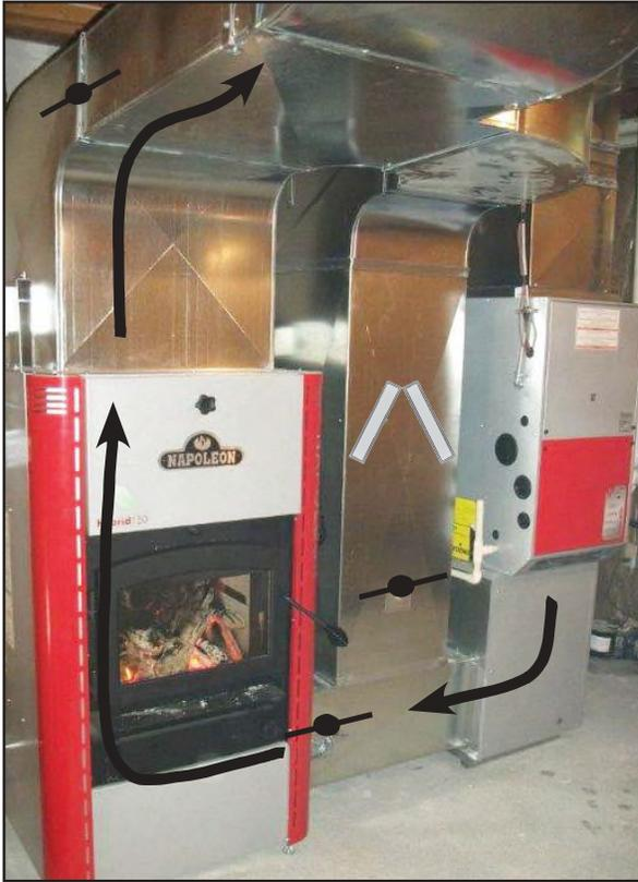
Les trois registres sont en position horizontale, bloquant la circulation d'air dans le plénum de dérivation et la forçant dans le cycle de la fournaise.
