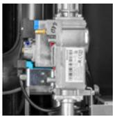
**Fonctionnement à basse pression.** La soupape de dépression permet d'assurer un rendement maximal jusqu'à 3,5" de colonne d'eau avec le gaz naturel et jusqu'à 8" de colonne d'eau avec le gaz propane.
