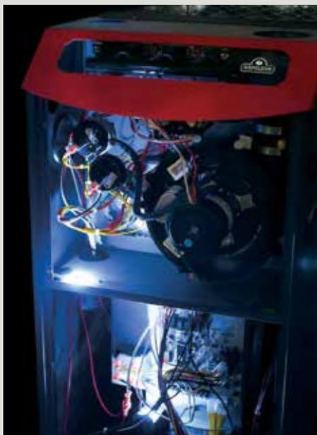
Lumières DEL intégrées dans les cabinets supérieur et inférieur qui s'allument automatiquement lorsque la porte de la soufflerie est ouverte.
